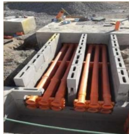
Tipo de canalización subterránea: trinchera
